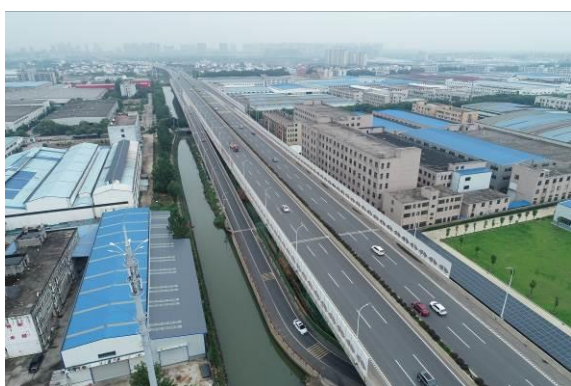
桥下边坡绿化
