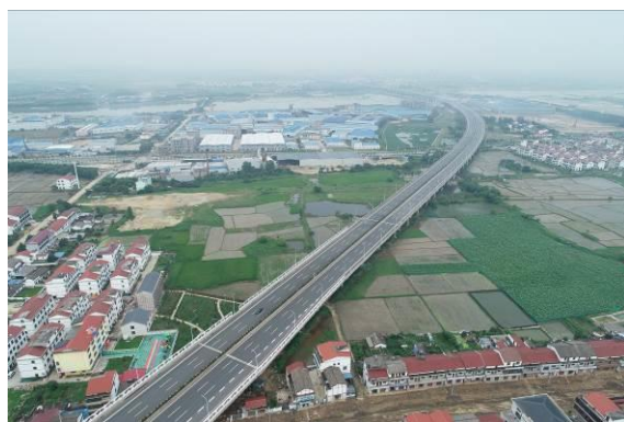
桥下边坡绿化
