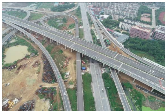
桥下边坡绿化
