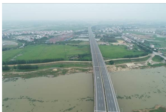
桥下边坡绿化
