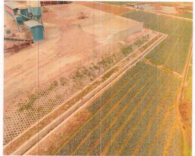
K4+300 停车区边坡实施六棱块护坡并植草防护，坡脚修建了排水沟
