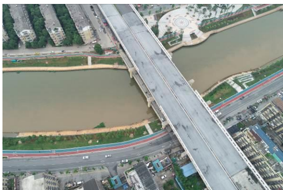
桥下边坡绿化
