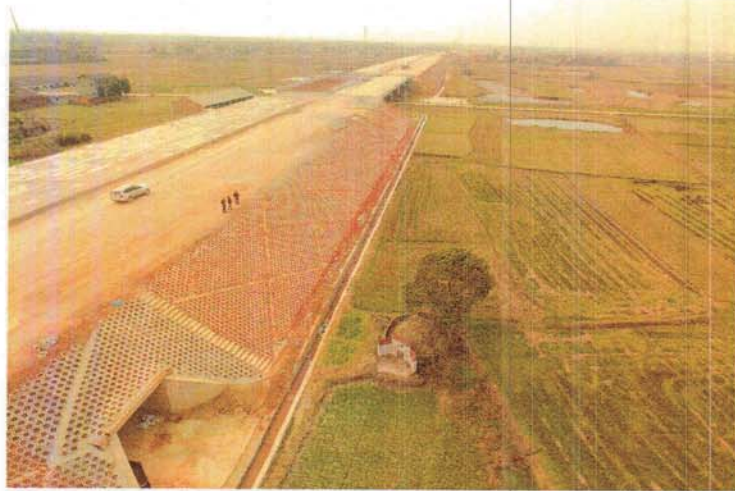
K2+600 主线边坡已实施六棱块护坡，坡脚修建了排水沟
