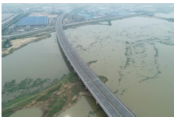
桥下边坡绿化
