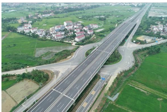
塔城互通（骨架护坡、排水沟、栽植乔木灌木）
