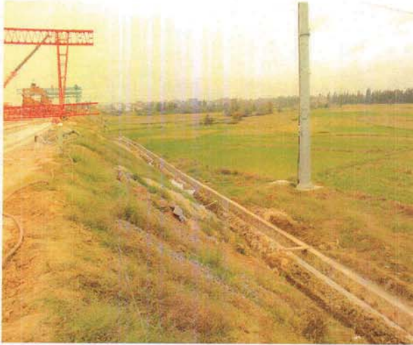
K1+200 右侧填方边坡已修建排水沟
